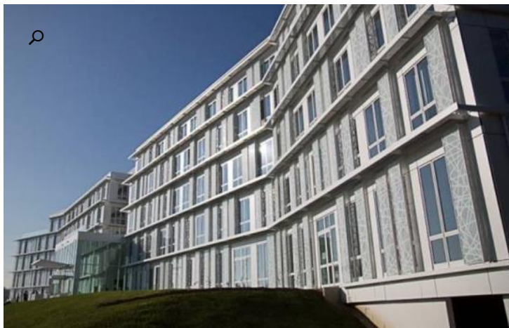
Cergy. Le groupe Spie, installé depuis 28 ans sur la commune, inaugure ce lundi son nouveau siège social dans le parc Saint-Christophe de Cergy. (DR.)
